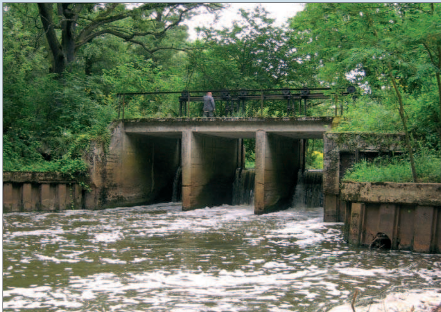
Jaz piętrzący wodę na potrzeby stawów w Dąbrowie, stan techniczny wskazuje na potrzebną wkrótce przebudowę, powinna ona uwzględnić techniczne rozwiązania udrażniające ciek, np. prześwit dolny lub pochyłe, kaskadowe spady w komorach jazu
