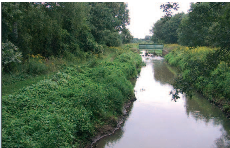
Nieżytkowany jaz na śródléśnym odcinku rzeki poniżej Bielic, do rozbiórki lub wykorzystania w ochronie przeciwpowodziowej (do zalewania polderu)
