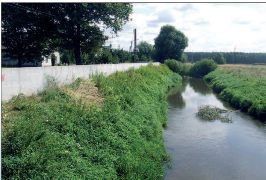
Przykład przemyślanego i nieinwazyjnego podejścia do ochrony przeciwpowodziowej – umocniony murem brzeg chroniący zabudowania Starych Kolni, przy jednoczesnym naturalnie kształtującym się korycie rzeki i możliwości szerokiego rozlania się wód powodziowych w dolinie
