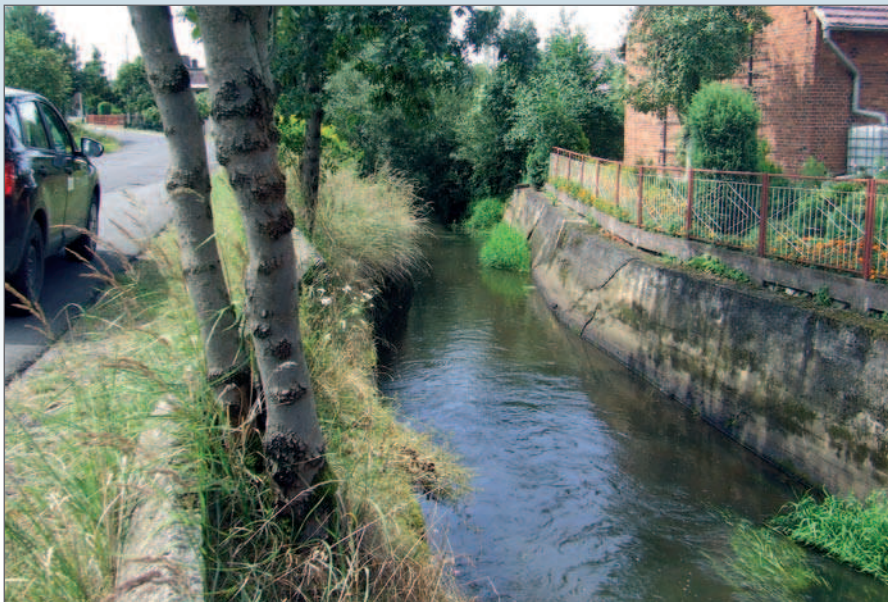
Umocnione koryto w Wierzbach, brak możliwości kształtowania korytarza migracyjnego rzeki, w przypadku dużych przepływów – zagrożenie powodzią
