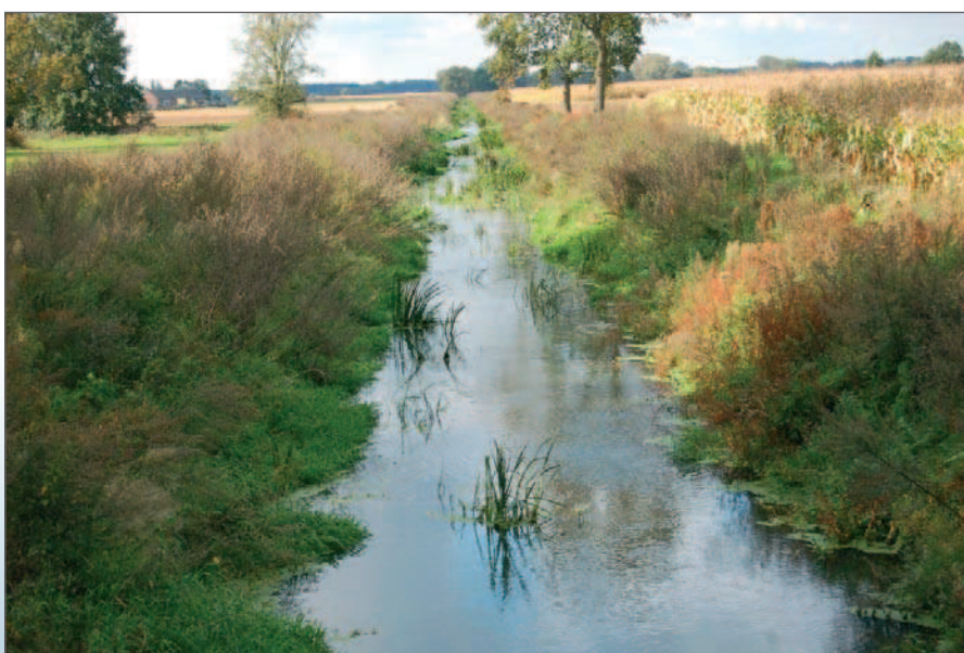
Ten sam odcinek, zarośnięty makrofitami, we wrześniu 2012 r. Przy tak zawężonej szerokości i takim wyprofilowaniu koryta rzeki, nie ma ona szans na wykształcenie naturalnego profilu cieku gwarantującego odpływ wody i naturalną strukturę brzegów.
