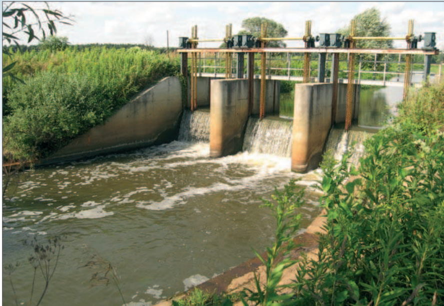
Jaz na wysokości Krogulna. Żaden z jazów na Stobrawie nie posiada przepławki, konstrukcja większości nie pozwala na swobodny przepływ podczas piętrzenia (tzw. dolny prześwit)
