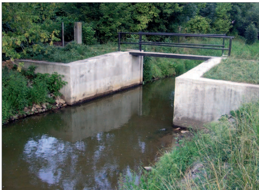
Nieużytkowana, prawdopodobnie od wielu lat, budowla, niebezpiecznie zawężająca koryto rzeki w obszarze zabudowanym w granicach Kluczborka
