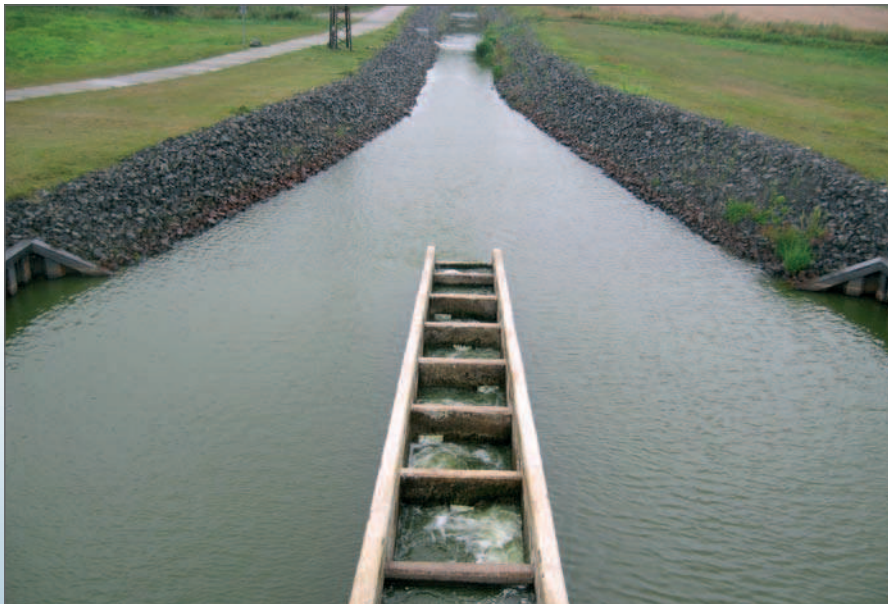
Przepławka na upuszczenie wody ze zbiornika w Kluczborku
